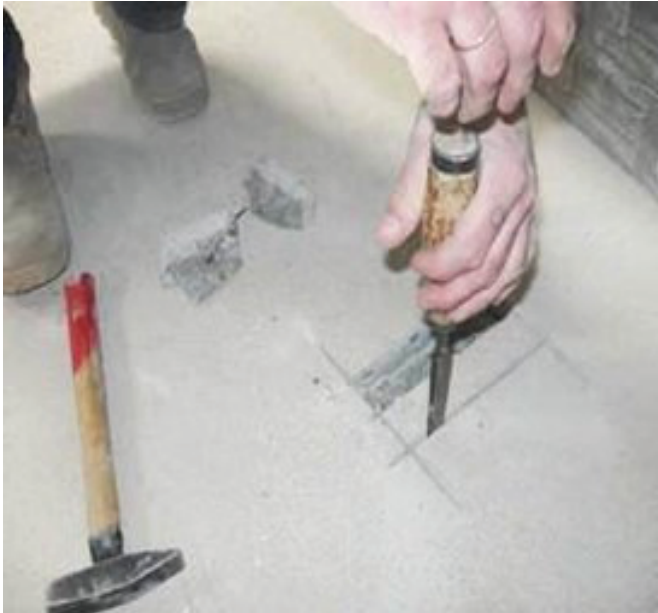
Рис. 1. Отбор вырубki из затвердевшего раствора стяжки пола Fig. 1. Removal of cutting from hardened solution of floor screed
