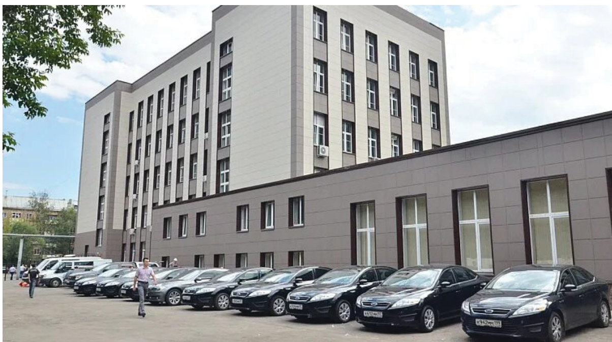
Рис.1. Общий вид здания. Отапливаемая площадь помещений S_{от} = 4189 \text{ м}^2 , отапливаемый объем V_{от} = 19794 \text{ м}^3 .
